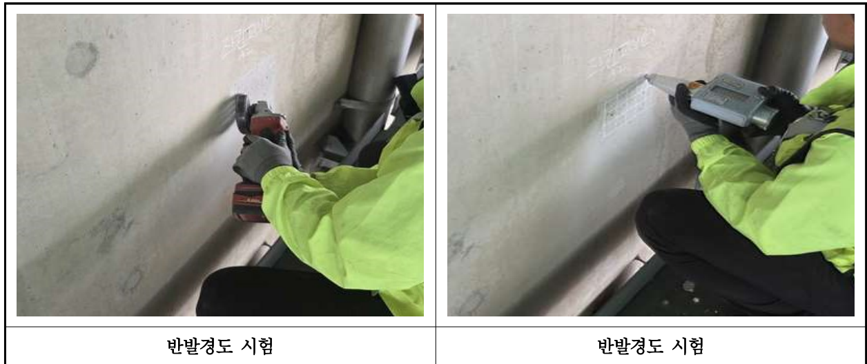
【사진 44.4.2】 반발경도시험 현장사진
