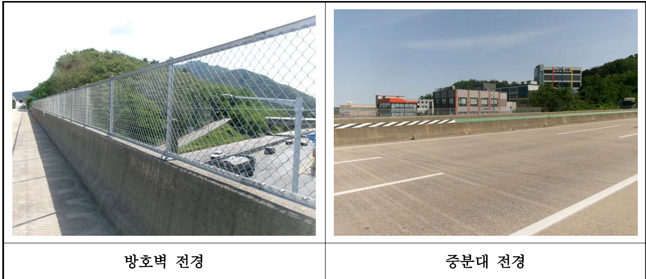
【사진 44.3.22】 방호벽 및 중분대 전경
