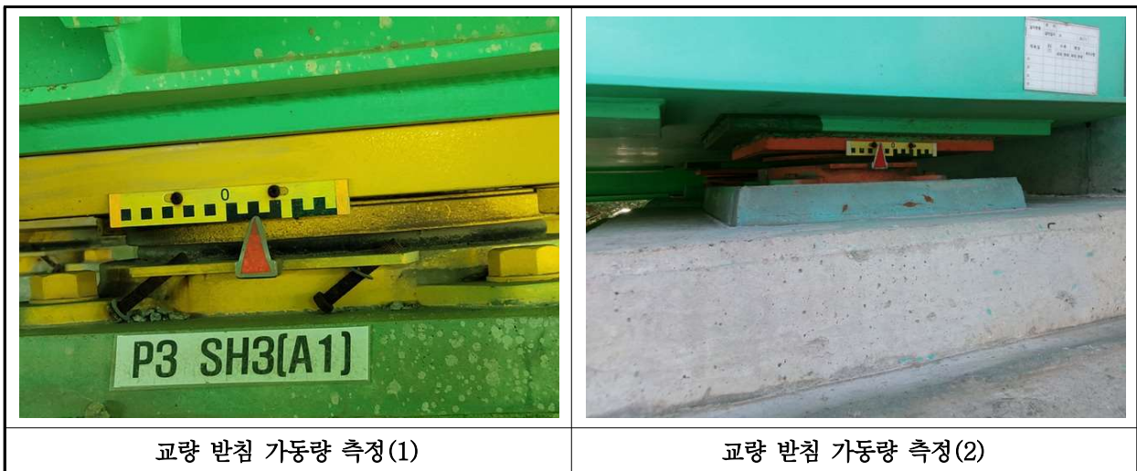
【사진 44.3.14】교량받침 이동량 측정
