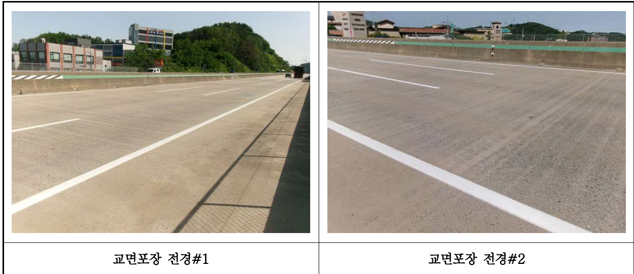
【사진 44.3.18】 교면포장 전경
