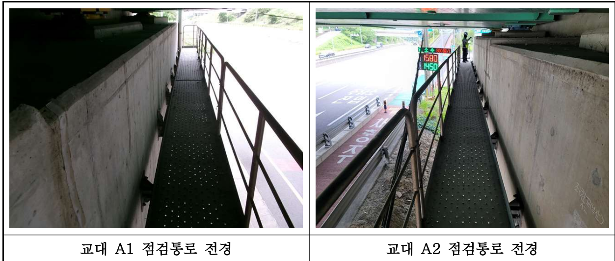
【사진 44.3.24】 교량 점검시설 전경
