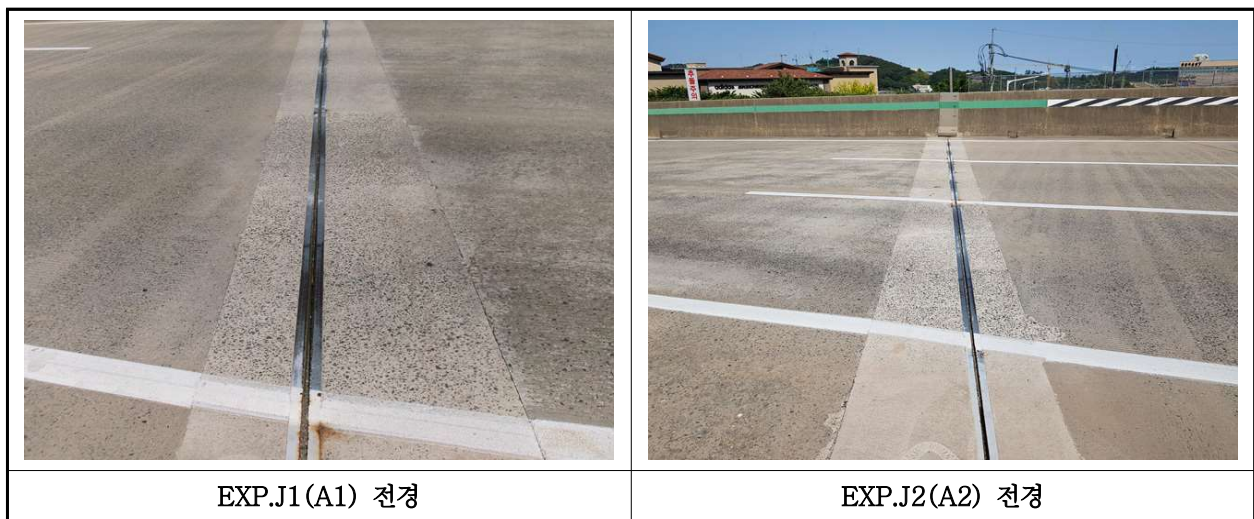
【사진 44.3.15】 신축이음장치 전경
