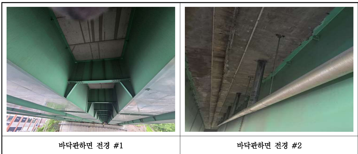
【사진 44.3.2】 바닥판하면 전경
