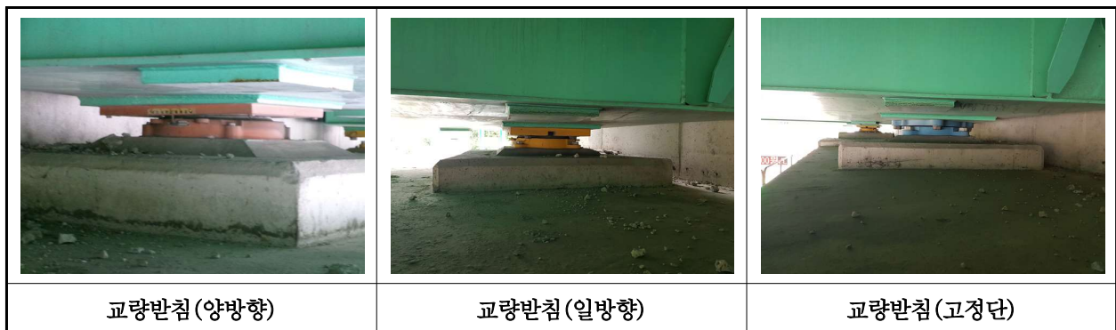
【사진 44.3.11】 교량받침 전경
