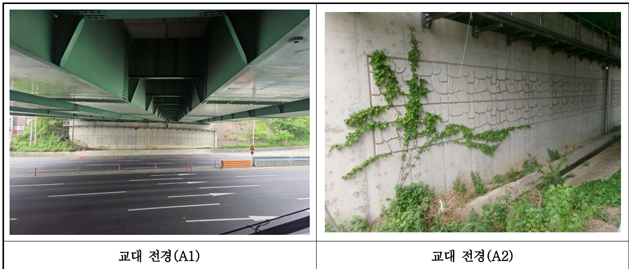
【사진 44.3.8】 교대 전경
