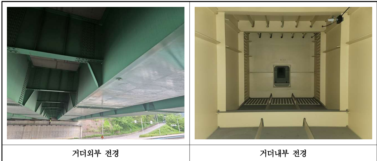
【사진 44.3.4】 거더 전경
