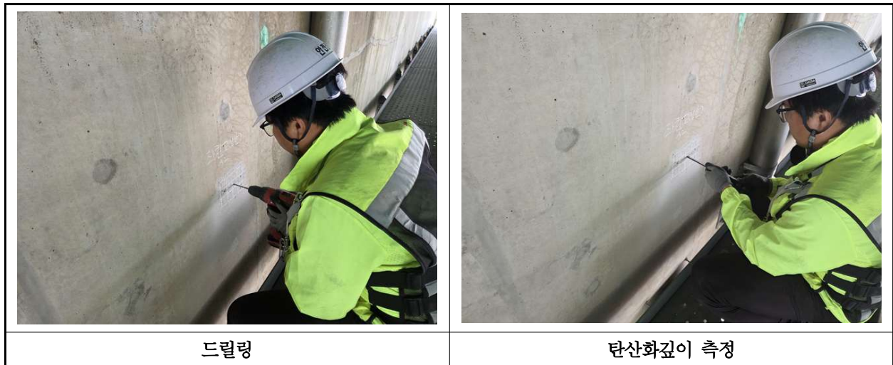
【사진 44.4.3】 탄산화 깊이 측정 현장사진
