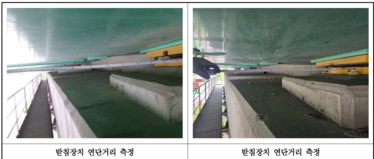
【사진 44.3.13】 교량받침장치 연단거리측정
