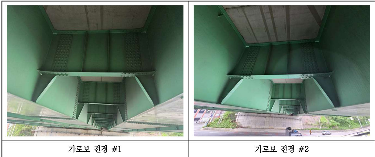
【사진 44.3.6】 가로보 전경
