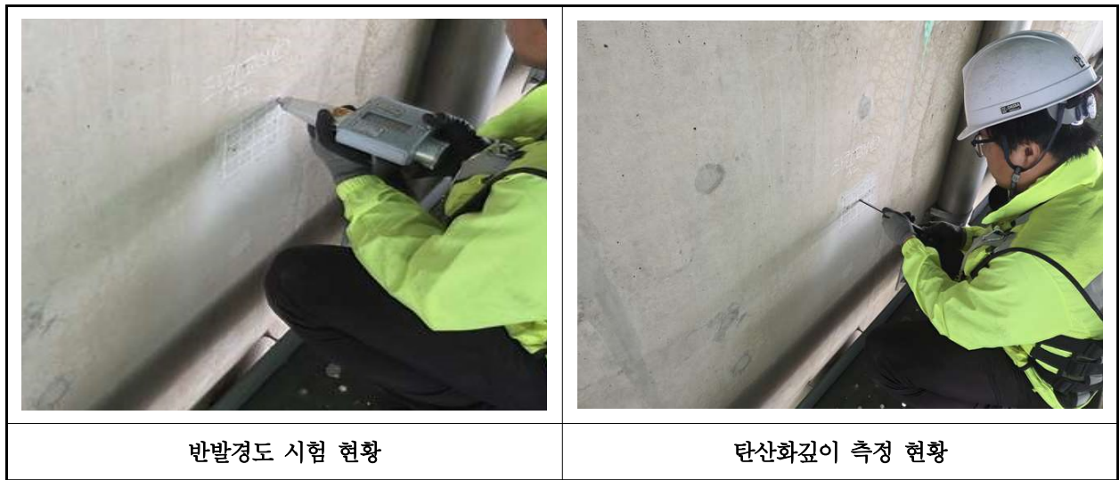
【사진 44.4.1】 콘크리트 내구성조사 현황
