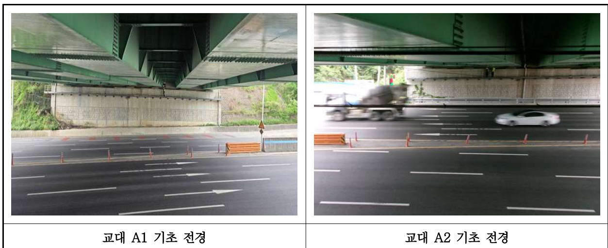
【사진 44.3.10】 기초 전경
