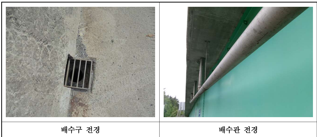
【사진 44.3.20】 배수시설 전경
